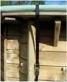
4 Sur l'autre largeur, passez les sangles dans les tendeurs (elles doivent dépasser de 10 cm afin de pouvoir appliquer une tension manuelle à l'aide des tendeurs à cliquet sur la couverture). Puis fixez les crochets à environ 45 cm sous la margelle.
