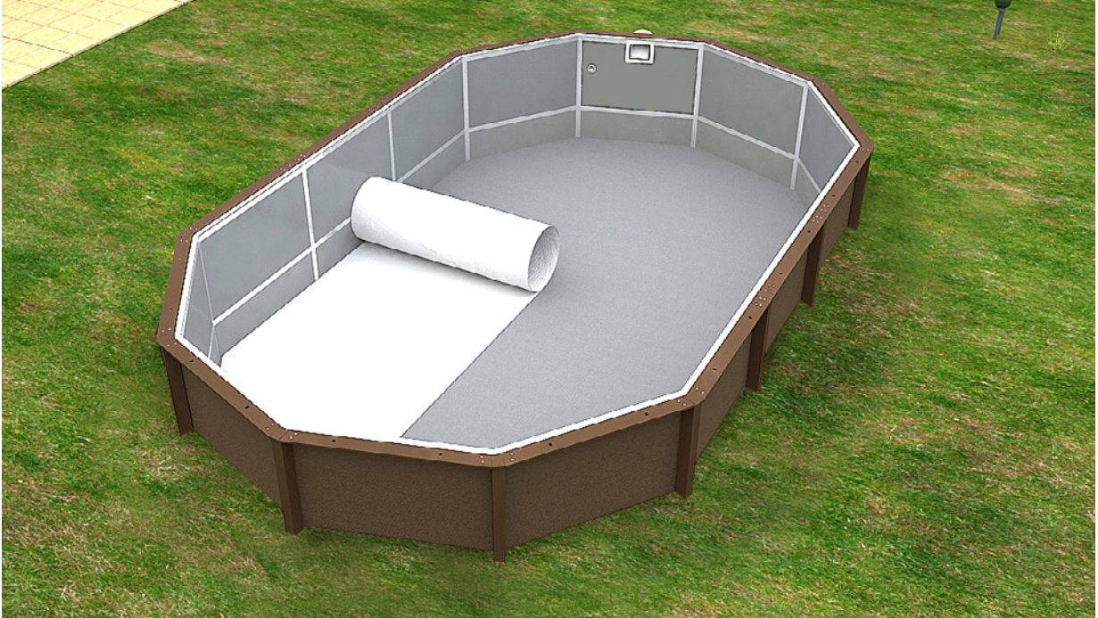
Emplacement du feutre Géotextil
